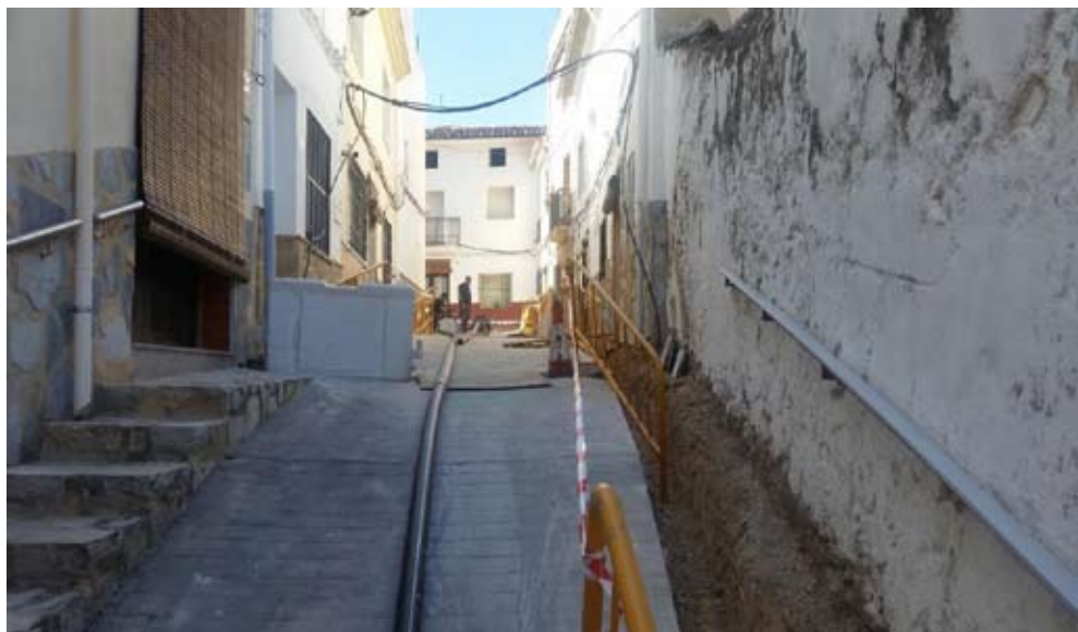
Fig. 27. Renovación de redes de distribución Agua Potable con tuberías de polietileno. Fuente: Elaboración propia.
