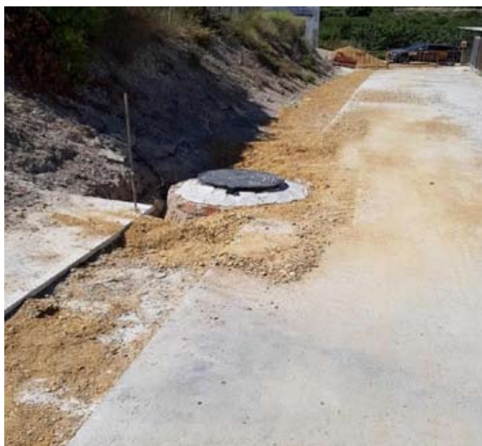
Fig. 26. Construcción de pozo de registro para Red de Saneamiento. Fuente: Elaboración propia.
