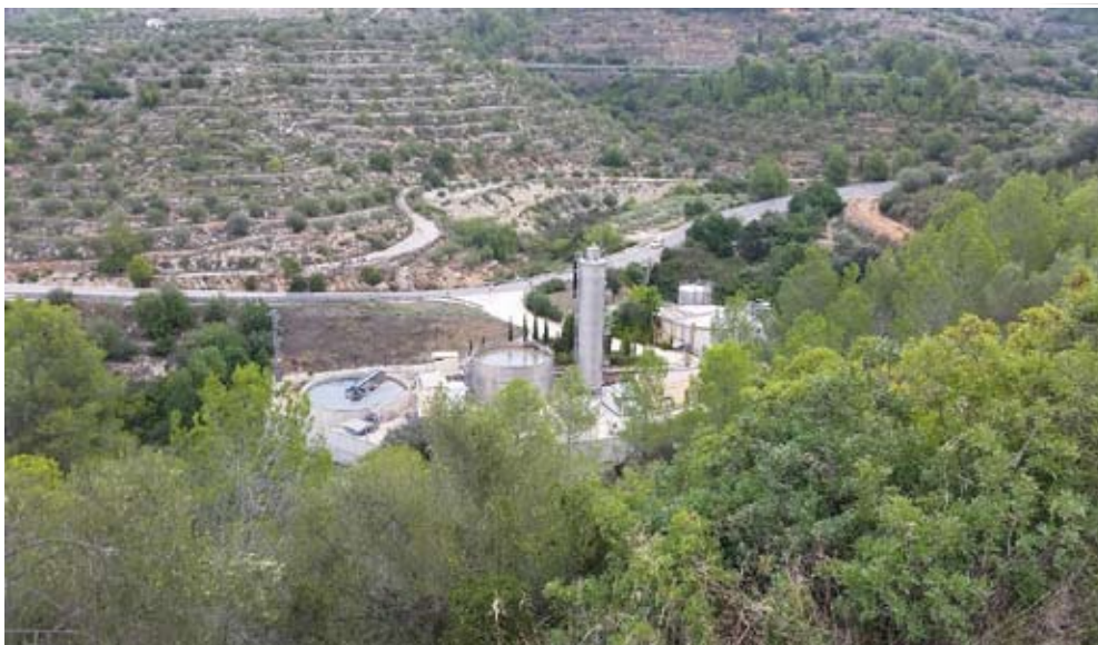
Fig. 24. EDAR de "Font Salem". Fuente: Elaboración propia.
