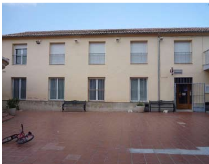
Fig. 39. Casa de la Cultura de Salem. Fuente: Elaboración propia.
