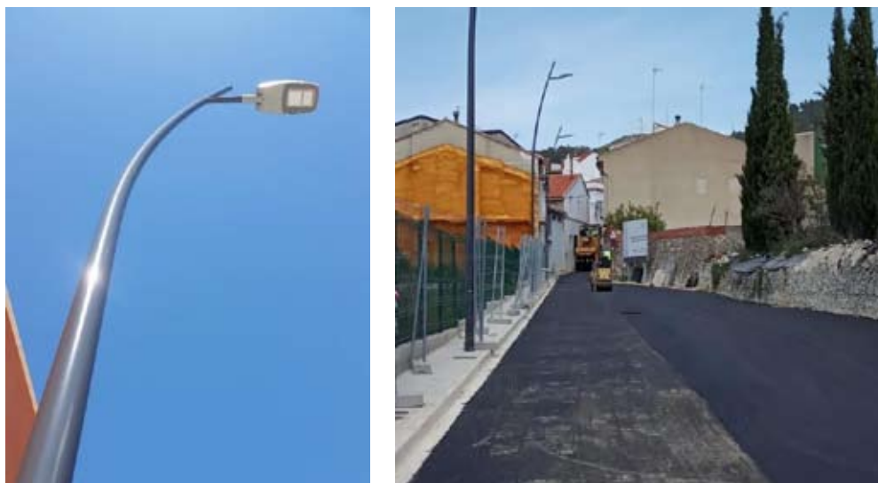
Fig. 37. Renovación del alumbrado público con luminarias LED. Fuente: Elaboración propia.
