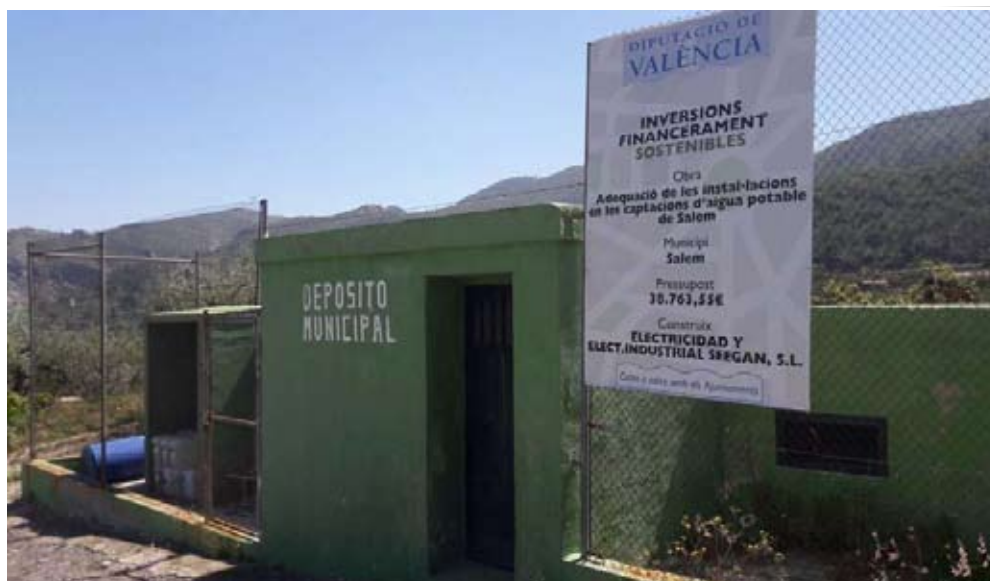
Fig. 29. Depósito municipal. Fuente: Elaboración propia.
