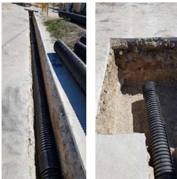
Fig. 25. Renovación de colectores de saneamiento a polietileno corrugado de doble pared. Fuente: Elaboración propia.
