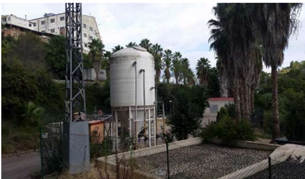
Fig. 23. EDAR de Salem. Fuente: Elaboración propia.
