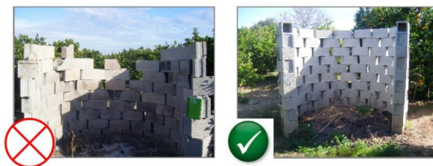
Manteniment de cremadors. Font: Norma Tècnica de Cremadors Agrícoles (PPIFD Polinyà del Xúquer).
