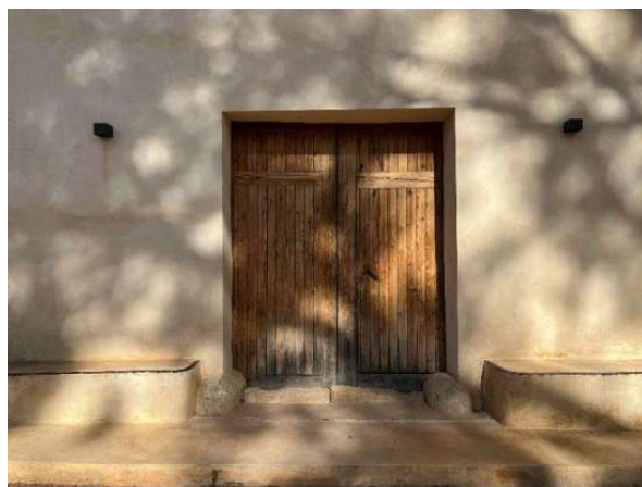
F17. Detalle carpintería y guardapuertas fachada interior conjunto (2023)
