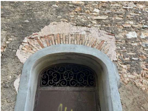
F14. Detalle arco de ladrillo en rosca fachada exterior norte (2023)
