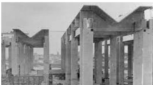
Colocación de Vigas y losas
